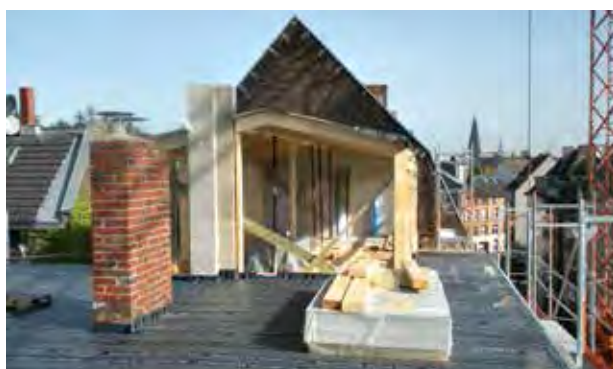
Baustelle mit Dom
